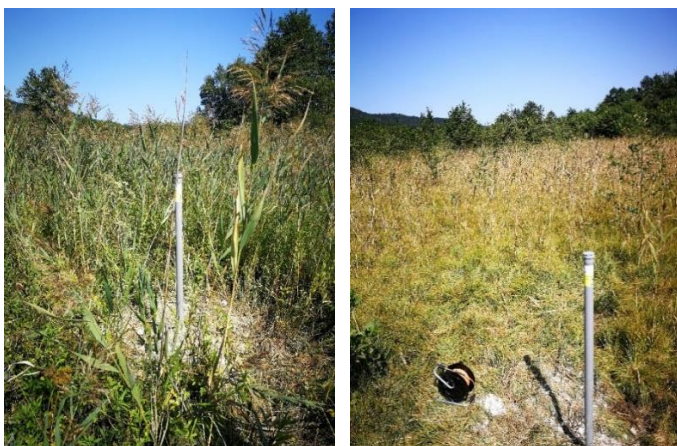
Slika 5, 6: Piezometer št. 1 (levo), št. 2 (desno).
