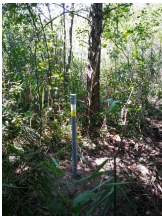
Slika 7: Izvedba piezometra št. 3, na lokaciji Marinčki.
