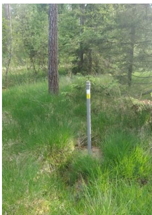
Slika 5: Izveden piezometer na območju
