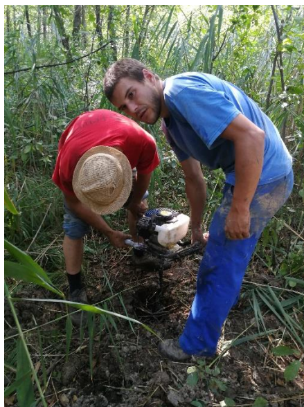
Slika 19,20: Vrtanje ter izvedba piezometra št. 3, na lokaciji Marinčki.
